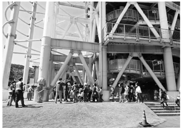
津波避難タワー見学の様子
