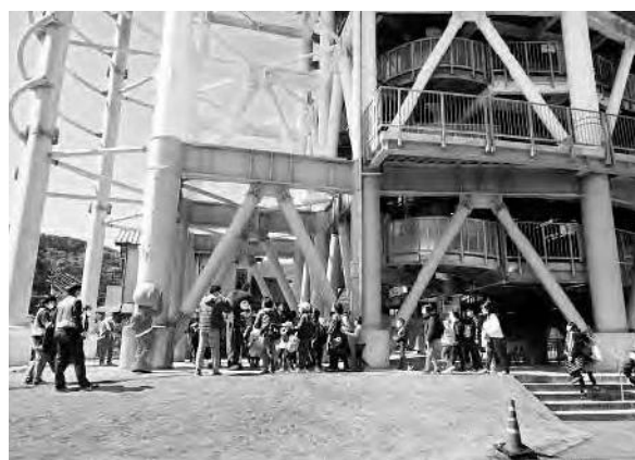
津波避難タワー見学の様子
