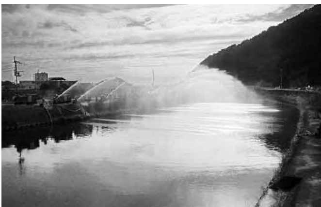
一斉放水の状況
