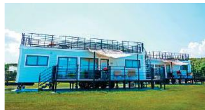
完成したグランピング施設
