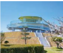
完成した展望台
