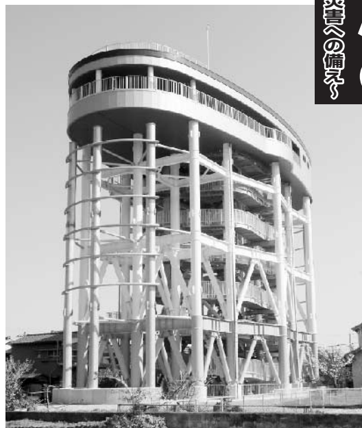
「今回完成した佐賀地区津波避難タワー」
