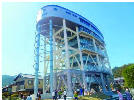
国内最大級 22mの津波避難タワー
