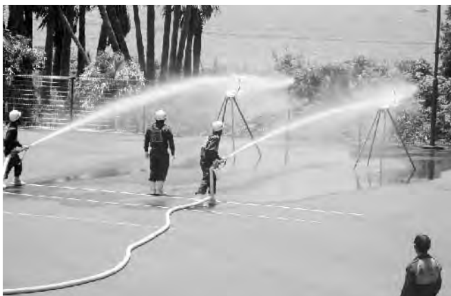
火点への放水状況
