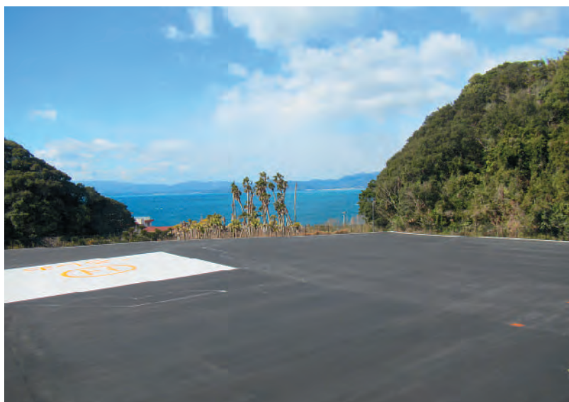
黒潮消防署南側の広場を舗装した、広さ約4800㎡の「避難広場」。
