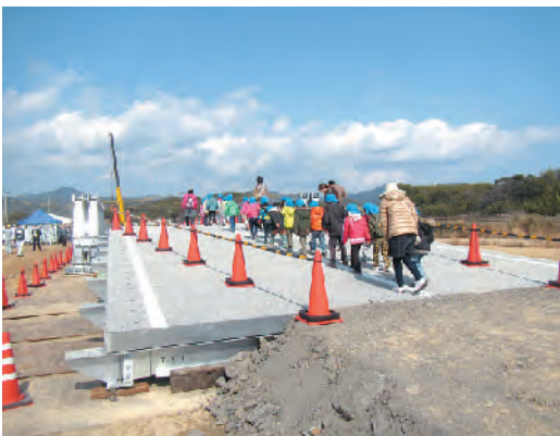
万が一のときは応急組立橋が地域の迅速な復旧に役立つことを信じています。
