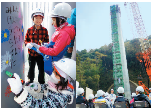
橋脚上部の鋼管に、絵や字を書く子どもたち。橋が架かればコンクリートで覆われて見えなくなる部分ですが、いい記念になりました。
