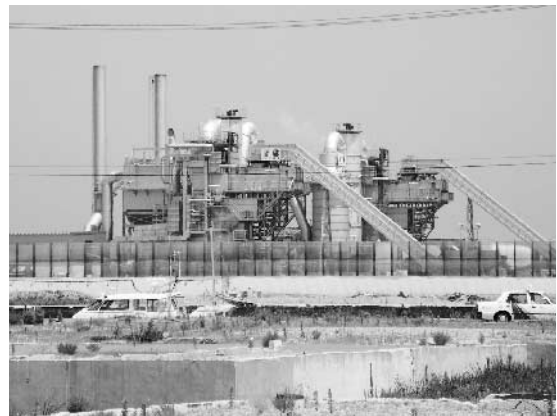
沿岸部に建てられた仮設焼却場
