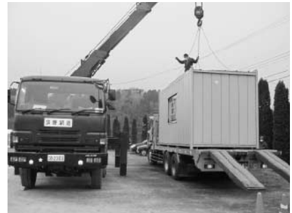
建設協会の提供で気仙沼市に寄贈したプレハブを自衛隊が設置
