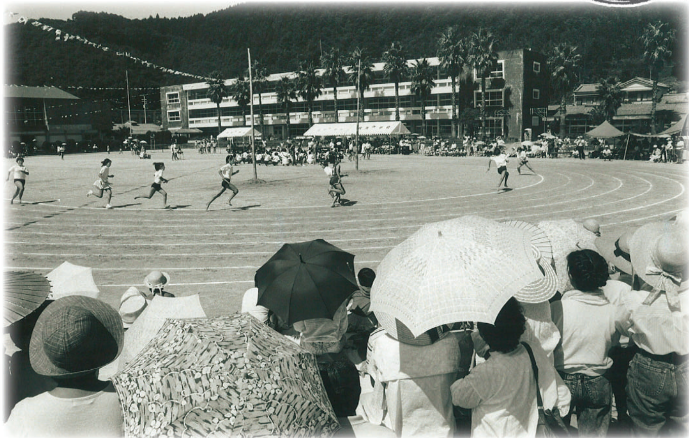
佐賀中学校の校舎建て替え工事のため、思い出がいっぱい詰まった学び舎は8月中旬には取り壊し工事に入ります。 写真は昭和56年ごろの体育祭の様子です。(写真提供：奈路広さん) 関連記事2ページ
