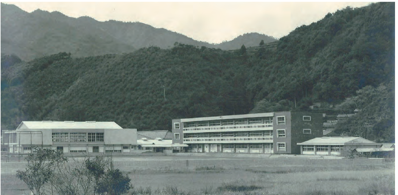
昭和42年、新築当時の校舎です。今では屋上まで伸びている教室の前のワシントン椰子はまだ植えられていません。この翌年度から拳ノ川中学校と合併し、旧佐賀町唯一の中学校となりました。その頃221人いた全校生徒は、現在87人。2階には空き教室が目立ちます。入学式、クラブ活動、文化祭、卒業式。思い出がいっぱい詰まった学び舎は、まもなくその役目を終え新校舎にバトンタッチします。(写真:昭和42年度卒業アルバムより)
