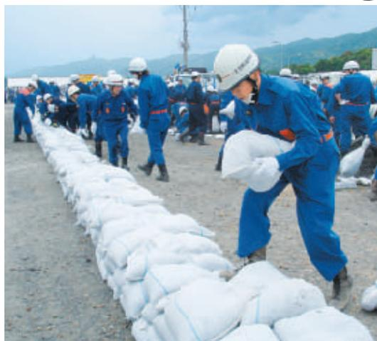
土のう積み工に励む消防団員。洪水により堤防などを水が越してきた場合、土のうを用いて浸水を防ぎます。
