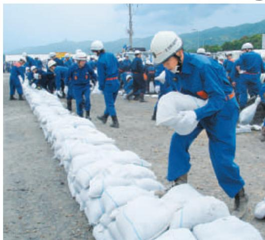
土のう積み工に励む消防団員。洪水により堤防などが水が越してきた場合、土のうを用いて浸水を防ぎます。
