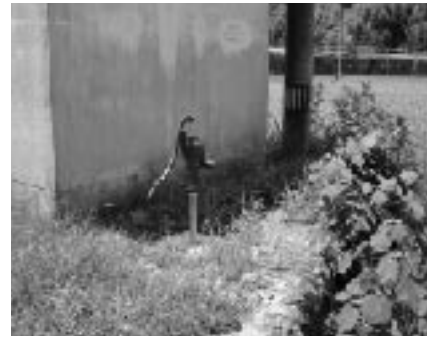
伊与喜小学校のプールポンプ室の横
