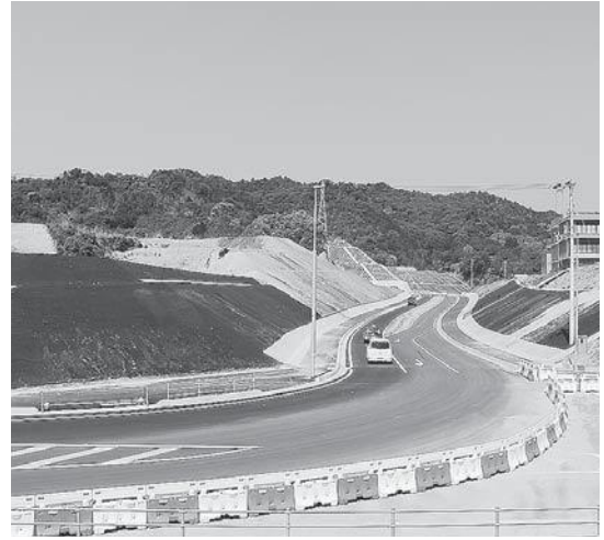
万行第一団地、同第二団地の移転計画が進む町道新庁舎防災広場線を挟んだ新庁舎西側の高台。今後、造成を経て平成33年度から建築工事を予定
