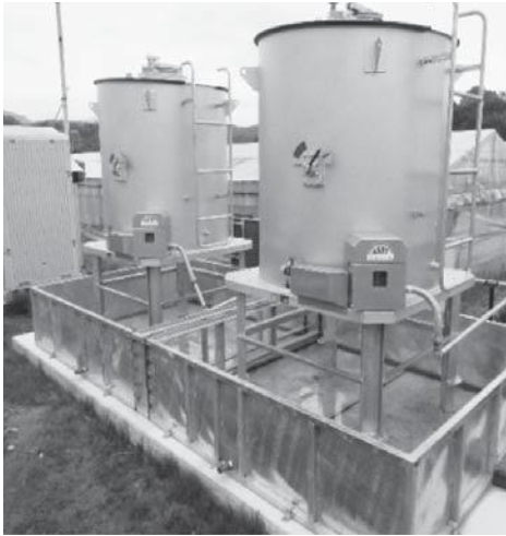
新設された耐震燃料タンク
