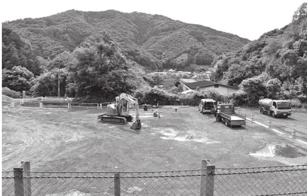
工事が進む佐賀保育所（仮称）中央奥には伊与喜小学校や集落が見える（6月下旬、東側より望む）
