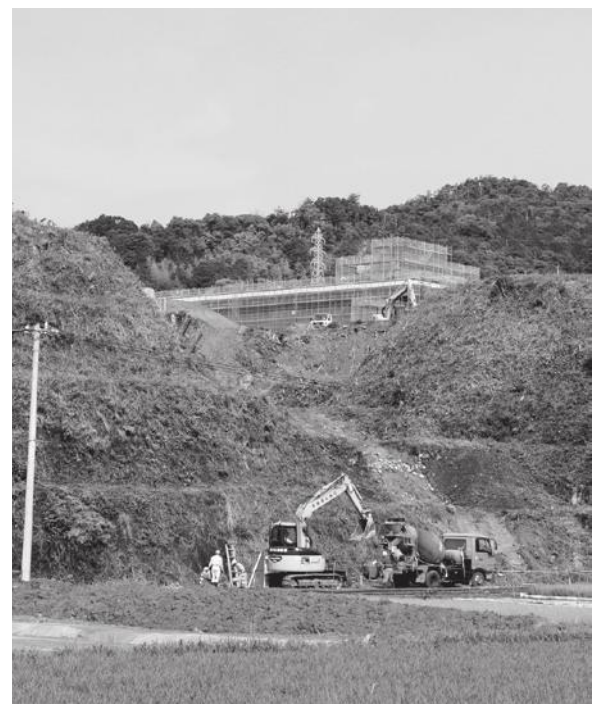
新庁舎をバックに工事中の2号調整池 (6月下旬、サンシャイン大方裏より望む)
