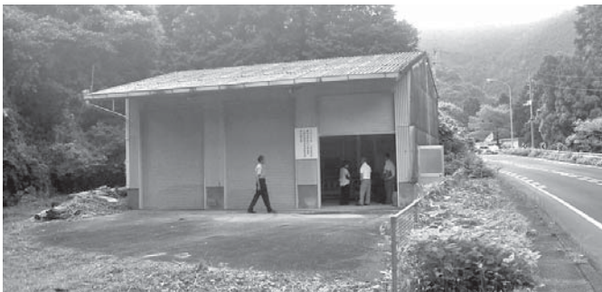
農林業基盤整備用機械施設(不破原)
