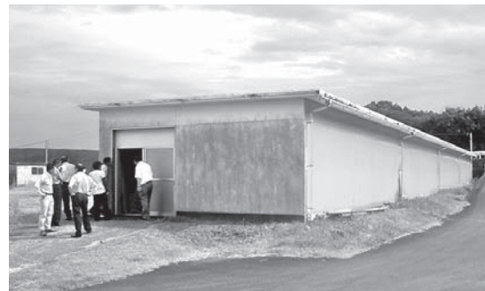
漁船漁業用作業施設(灘漁港)
