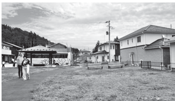
高台移転の促進状況(気仙沼市)
