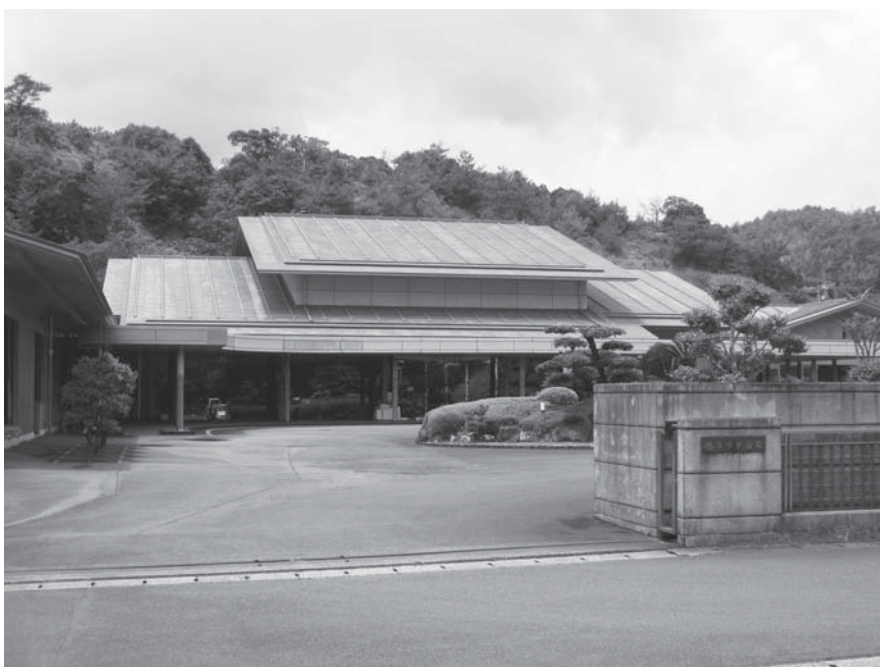
改修が望まれる幡多中央斎場
