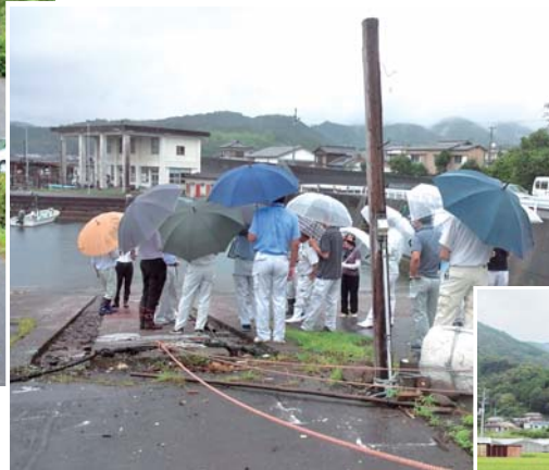
▲ 旧船揚場の段差解消の要望箇所を。(伊田漁港)
