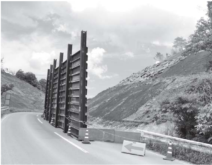
竹島側から見た工事現場。当日は、猛暑の下、表面に貼られたモルタルをはく作業が(7月4日)
