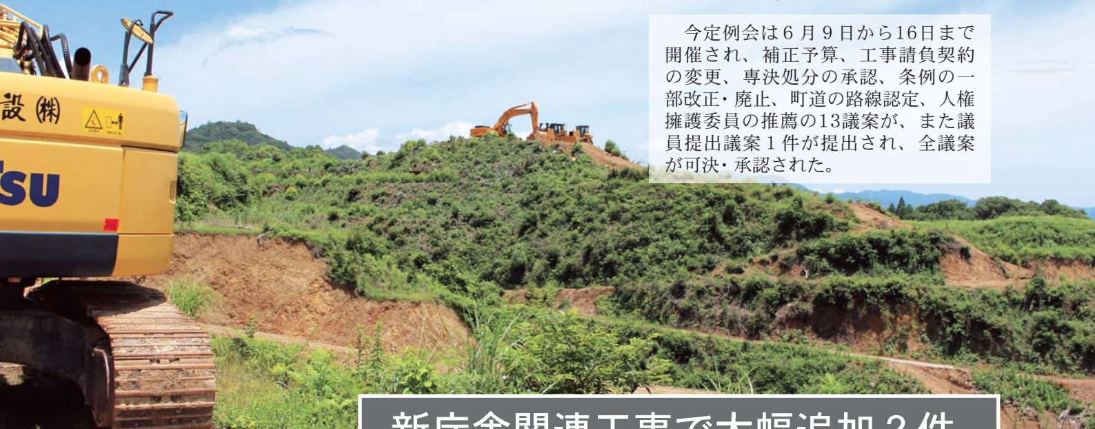
新庁舎（中央重機付近が予定地）建設用地造成工事の現況（7月1日撮影）
