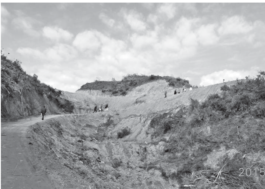
新庁舎建設予定地の現況（H27年12月15日）
