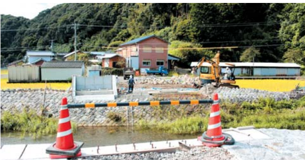
復旧中の法寿院橋 (有井川 H27年9月末撮)
