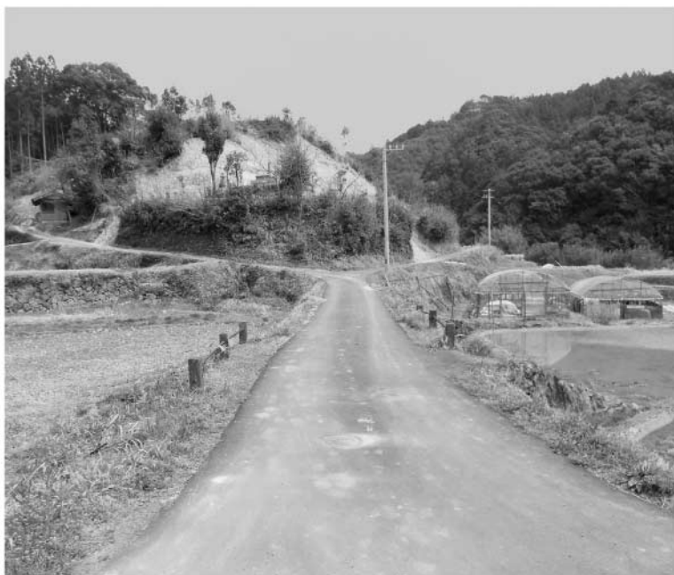
橋川集落から見る加持橋川線
