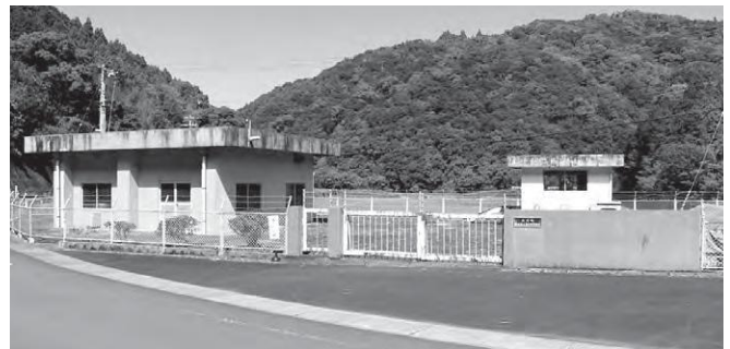
上水道上川口取水施設
