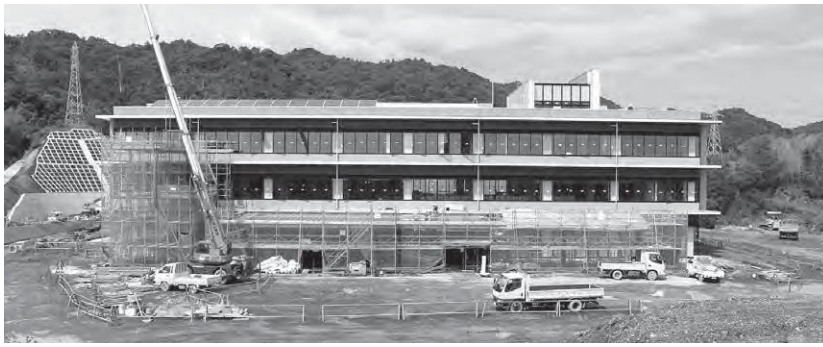
完成間近の新庁舎を正面玄関側から望む（10月3日）
