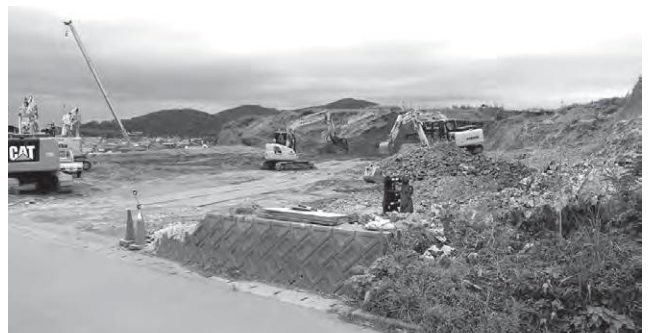
造成中の城山宅地を入野小学校西側から(10月5日)
