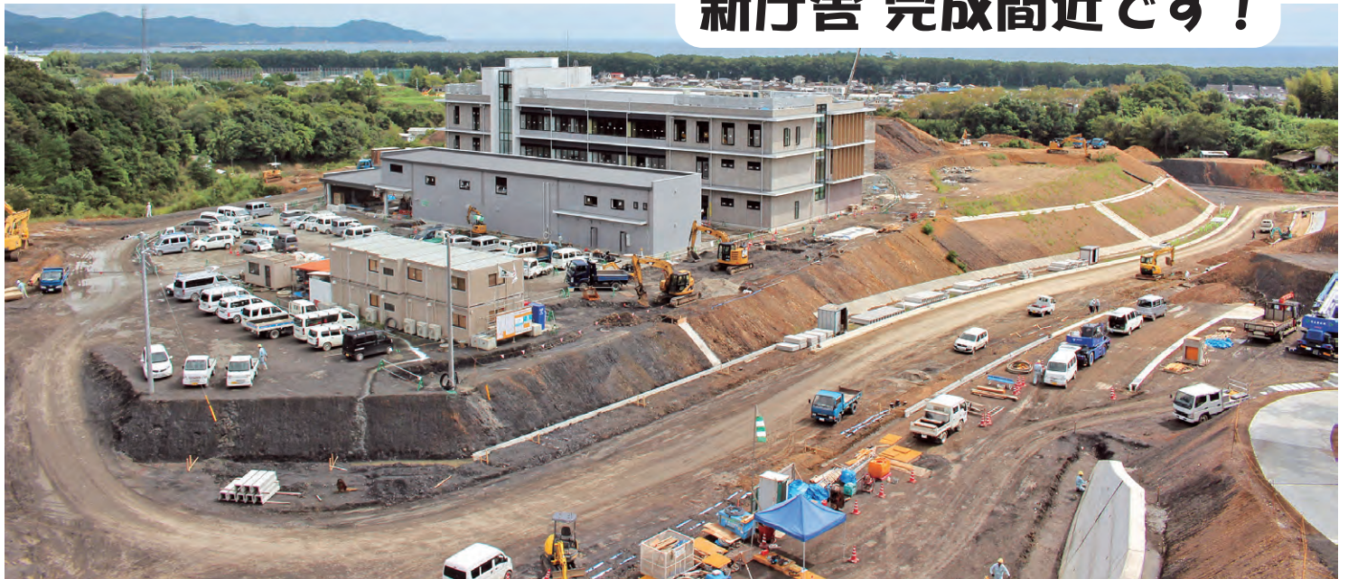
11月上旬の完成を目指し、工事も最終段階に（H28年10月3日）
