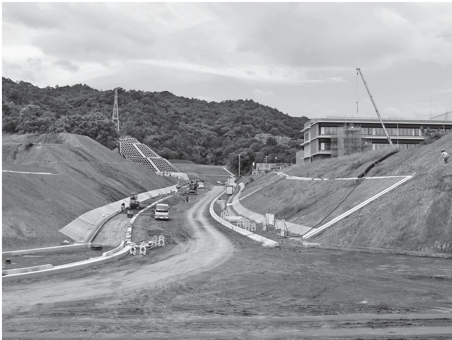
工事が進む町道新庁舎防災広場線を大方バイパス側から望む（10月3日）
