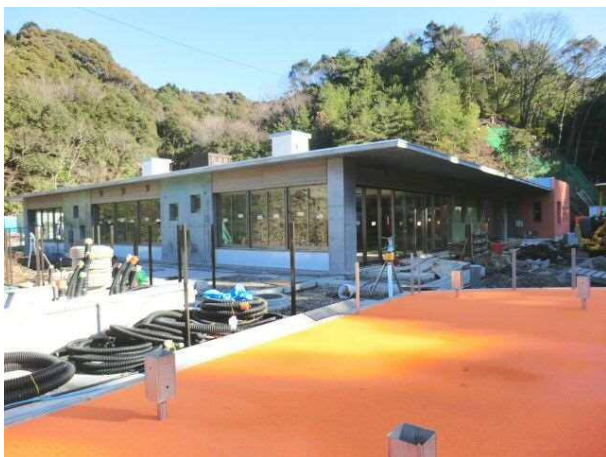
※写真は工事中のものです
