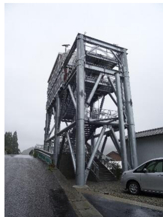
【5-15】 横浜津波避難タワー(4) [*JPG]
