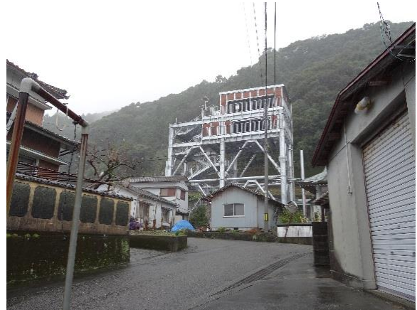
【5-13】 横浜津波避難タワー(2) [*JPG]
