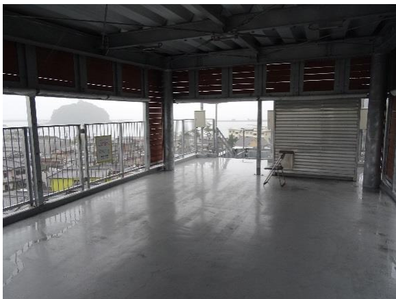
【5-14】 横浜津波避難タワー(3) [*JPG]
