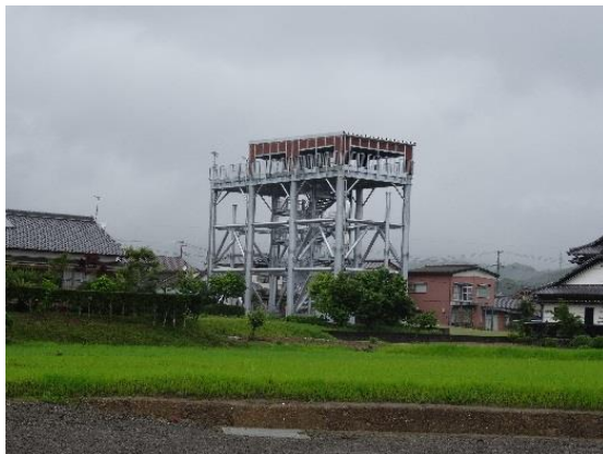
【5-1】早咲津波避難タワー(1) [*JPG]
