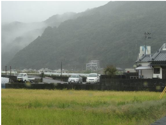
【5-12】 横浜津波避難タワー(1) [*JPG]
