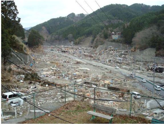
【9-5】資料2 東日本大震災による両石地区の被災状況（被災後）[*JPG]
