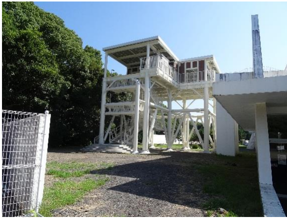
【5-5】 浜の宮津波避難タワー(1) [*JPG]
