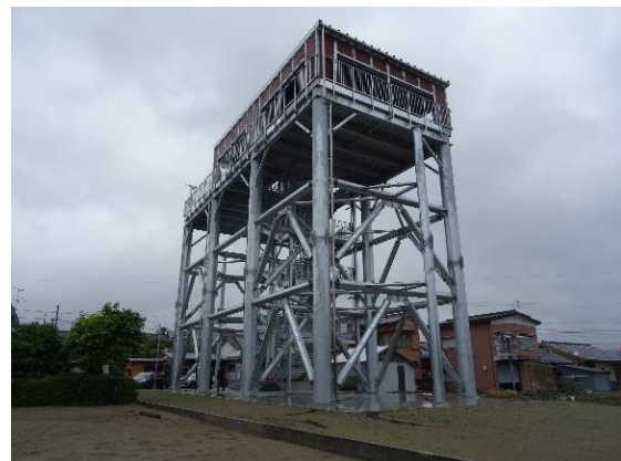
【5-2】早咲津波避難タワー(2) [*JPG]
