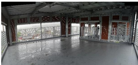
【5-3】早咲津波避難タワー(3) [*JPG]
