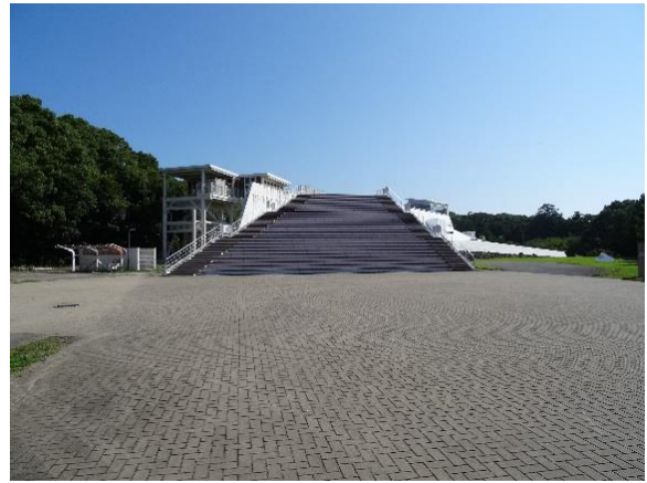
【5-6】 浜の宮津波避難タワー(2) [*JPG]
