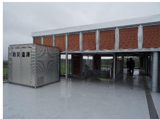
【5-4】早咲津波避難タワー(4) [*JPG]
