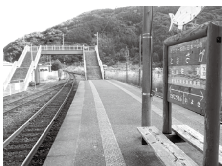
撤去予定の跨線橋(左側奥:土佐佐賀駅)
