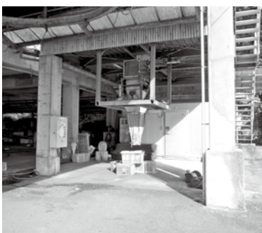
上川口港の製氷施設
