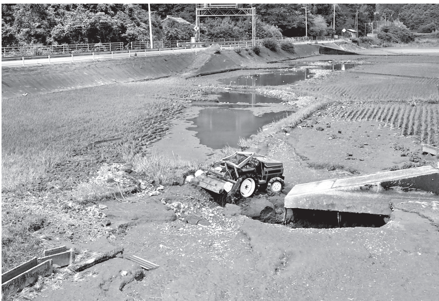
6月4日 大雨洪水の被災状況（不破原地区）
