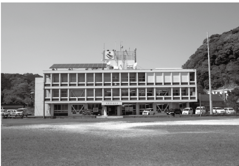
津波浸水区域内にある佐賀支所
