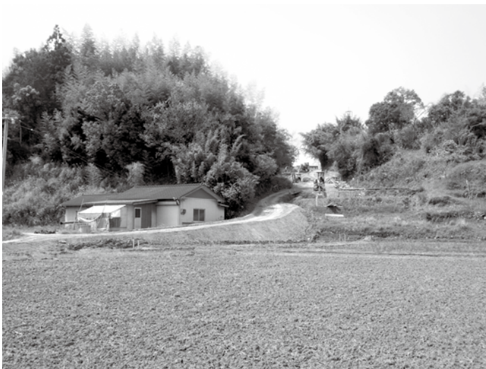
急ピッチで進む避難道拡幅工事（入野早咲地区）
