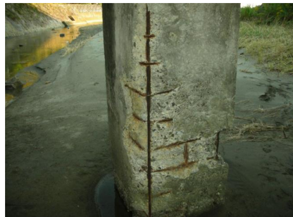
●橋脚の鉄筋露出
