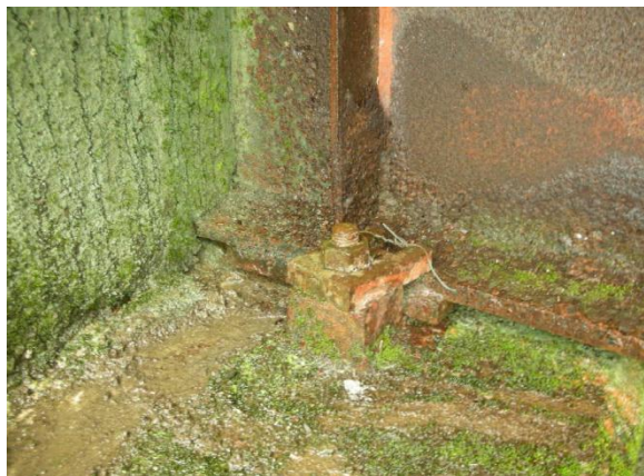
●支承の機能障害
