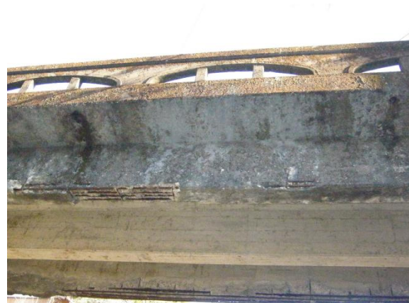
●コンクリートの鉄筋露出
