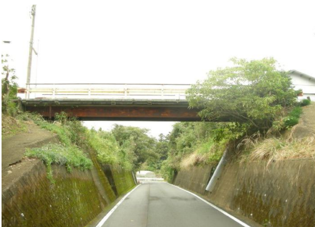
道路を跨ぐ橋の事例
