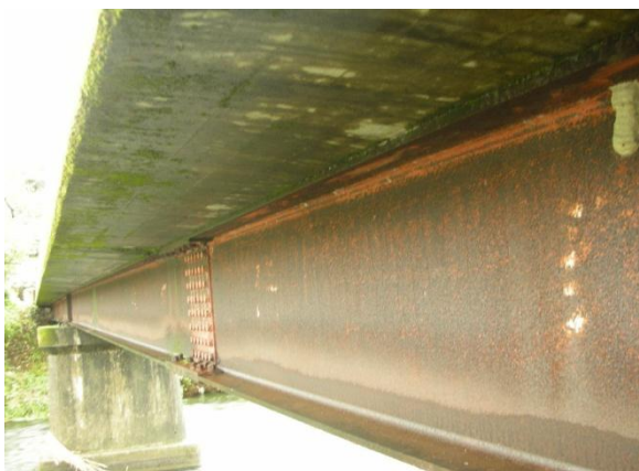
●鋼部材の腐食
