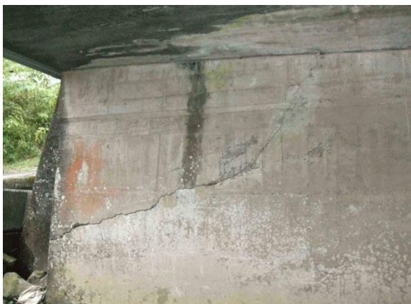
●コンクリートのひびわれ
