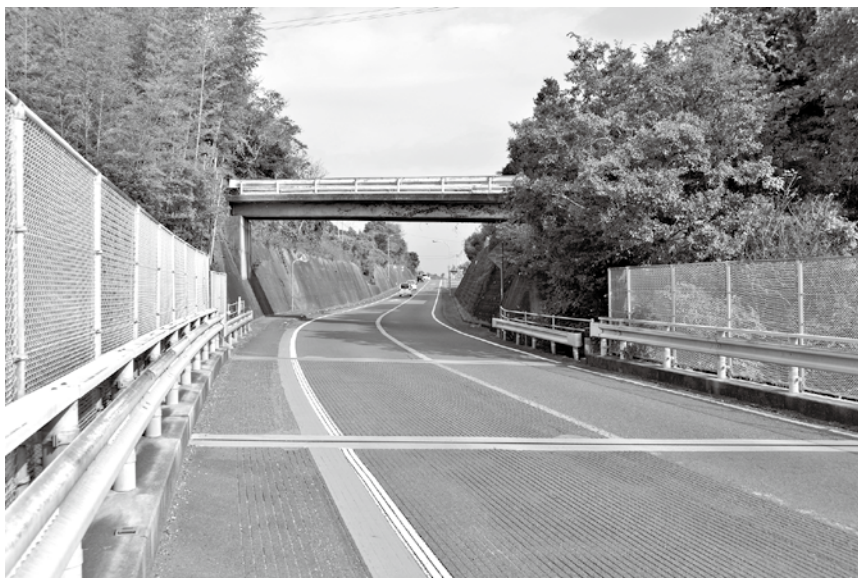
浮津の国道56号線上の陸橋
