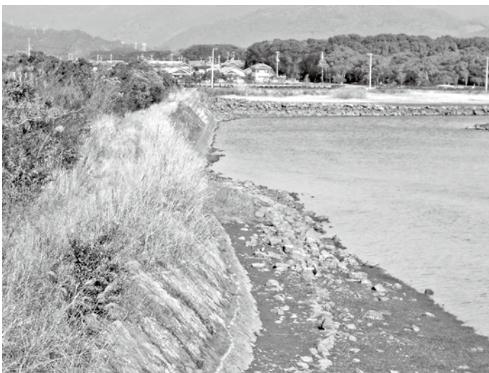
蛸瀬川左岸堤の様子
