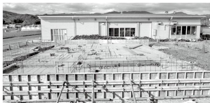
基礎工事中の缶詰工場 (入野早咲地区)
