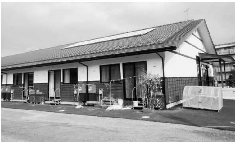
避災地に建てられた災害公営住宅
