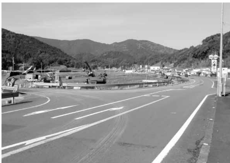
さが道の駅建設進む
