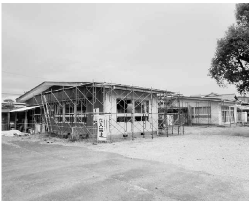
屋根の改修中（旧早咲保育所）
