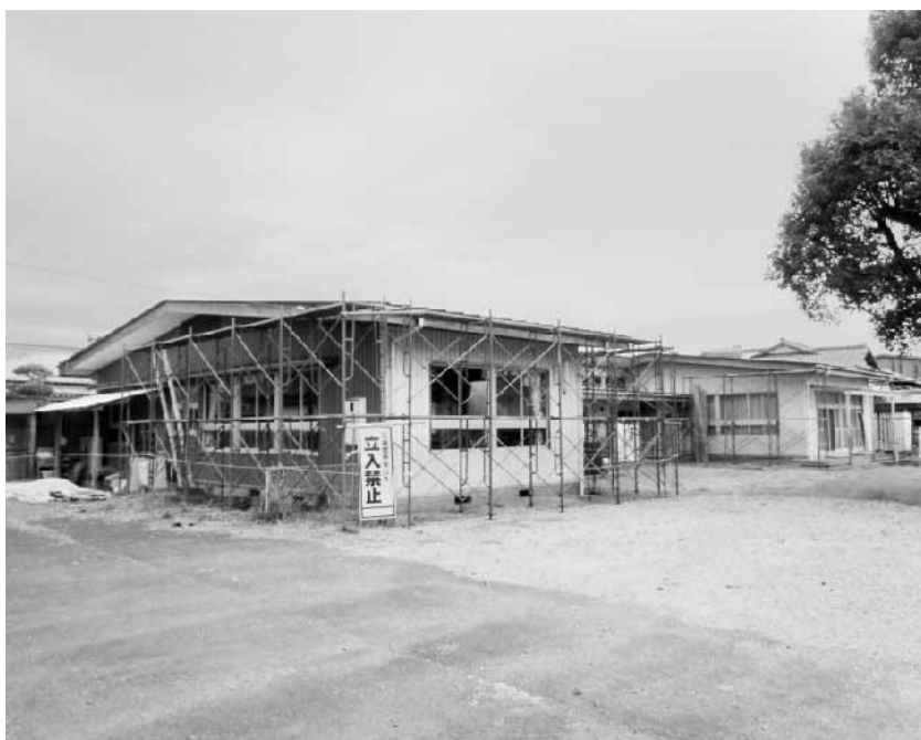
屋根の改修中（旧早咲保育所）
