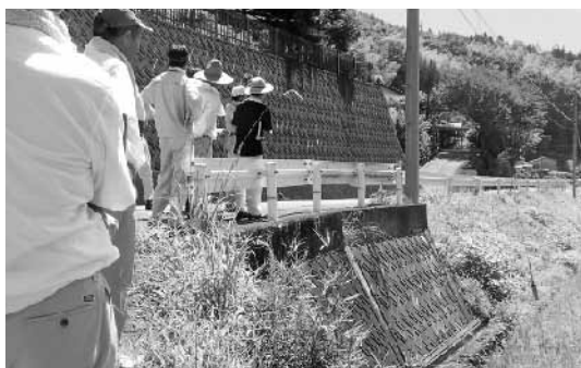
大井川保岐県道改良予定地
