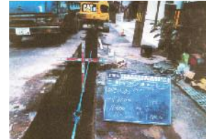
耐震管に布設替
