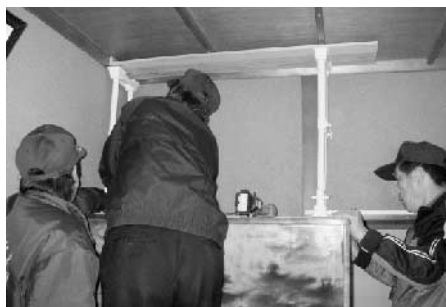
伊田分団OBたちによる家具の固定作業の様子
